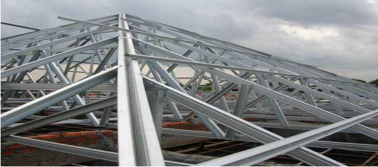
3. ábra. Fém tetőszerkezet.
